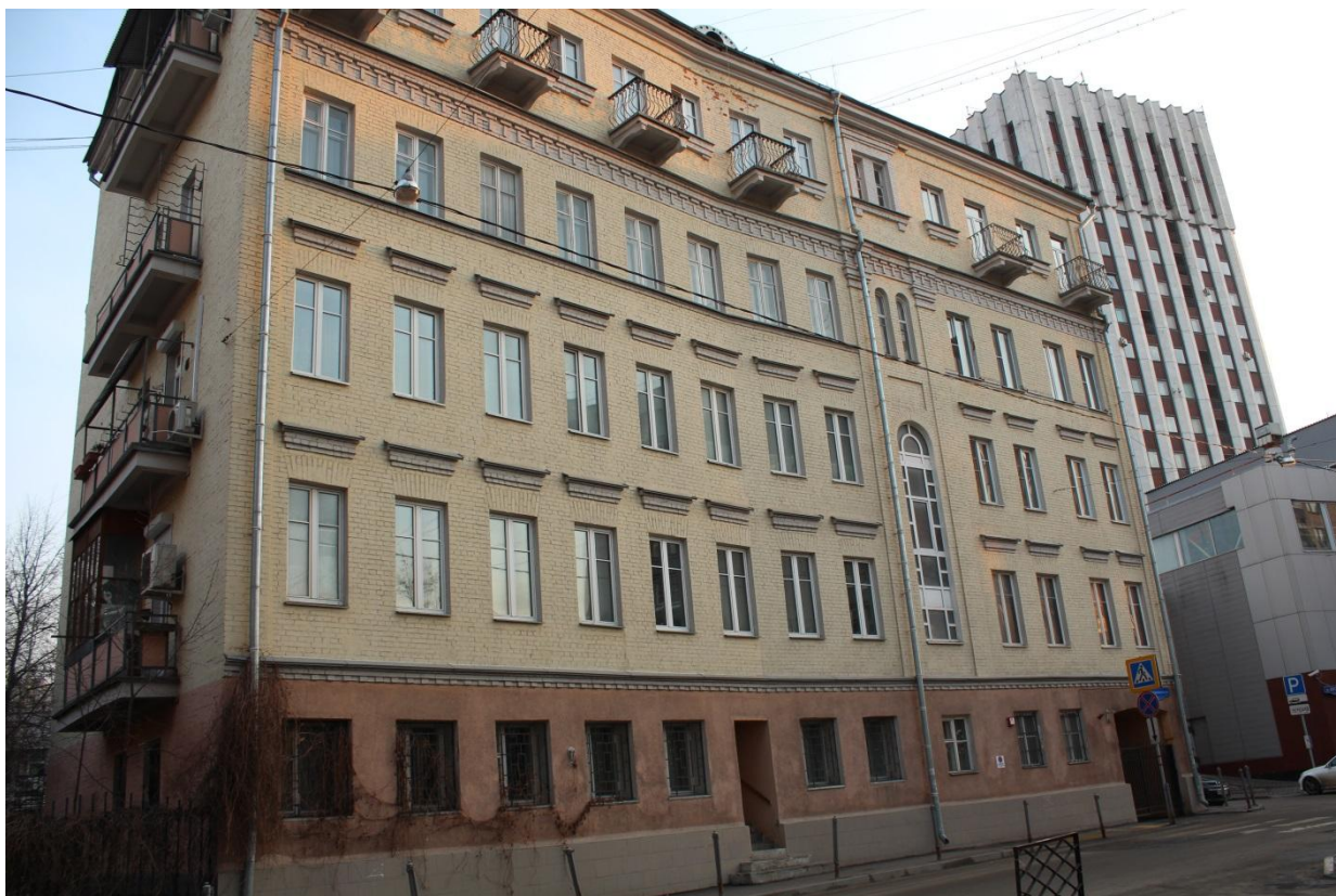
Рис. 1.1. Фасад объекта реконструкции
